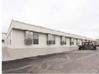
CENTROS DE CONTROL
