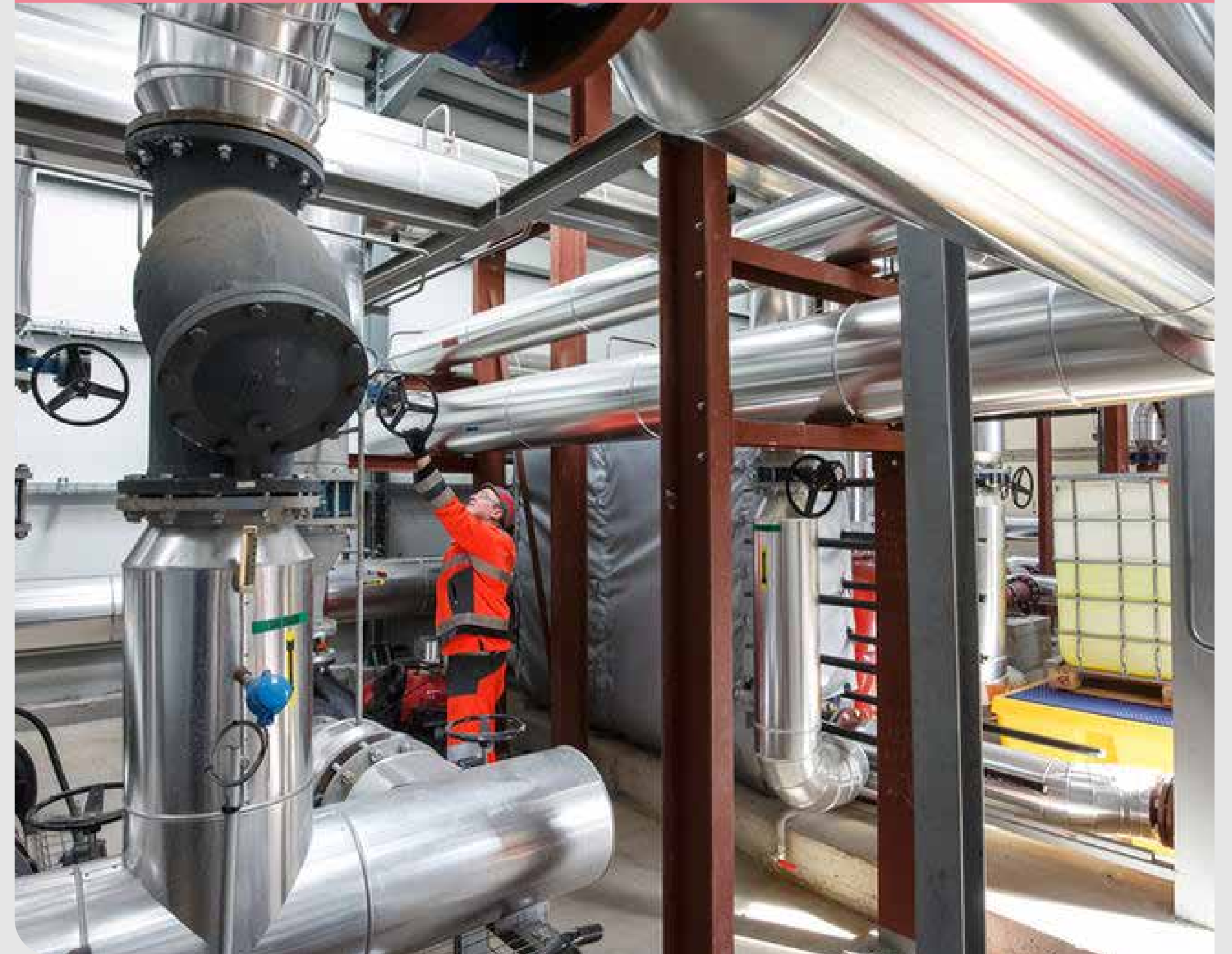
Tratamiento de lodos
