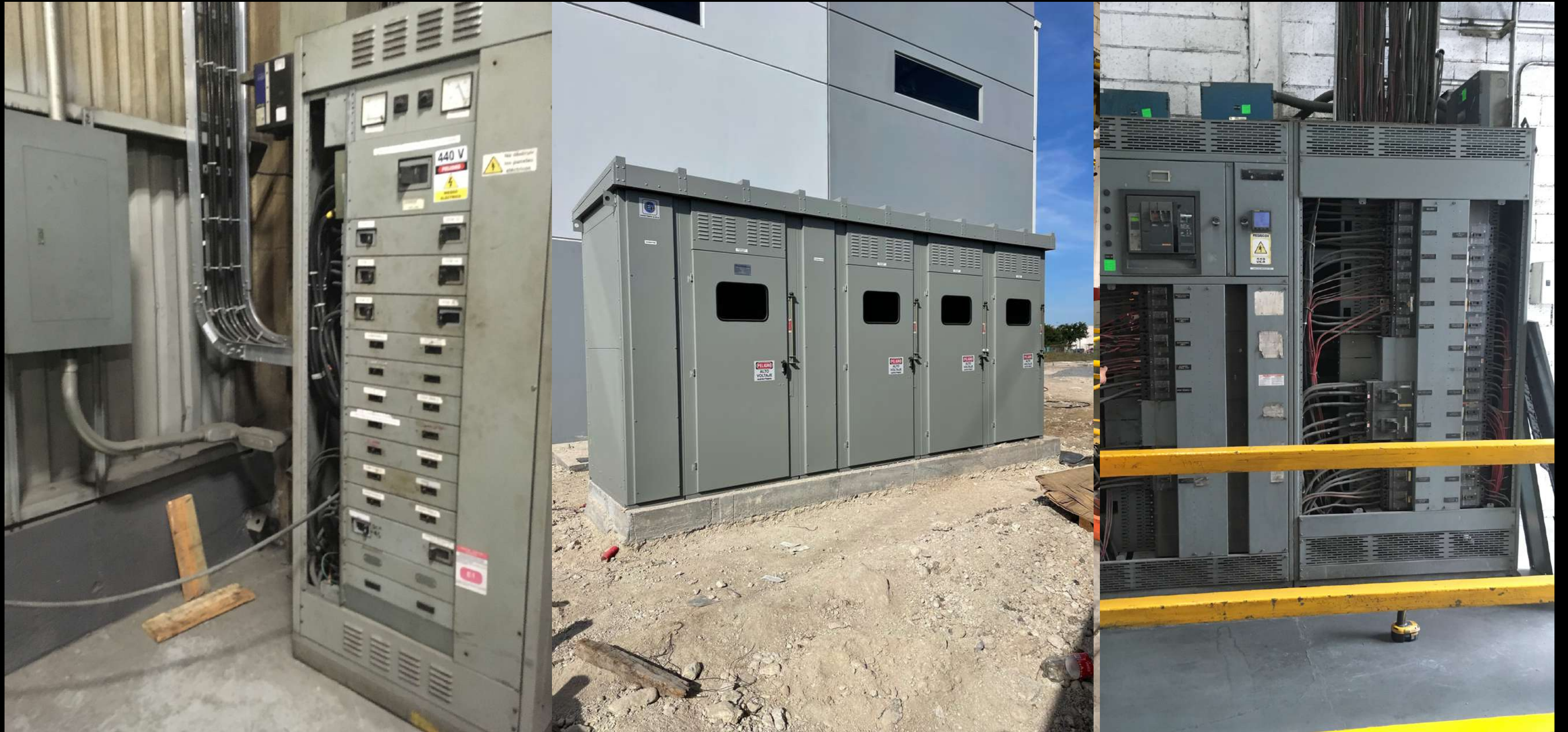
INSTALACIÓN DE TABLEROS DE DISTRIBUCIÓN Y CENTROS DE CARGA
