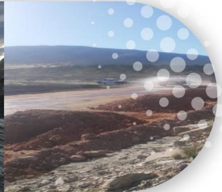
Conformación de taludes y bermas con enrocamiento.
